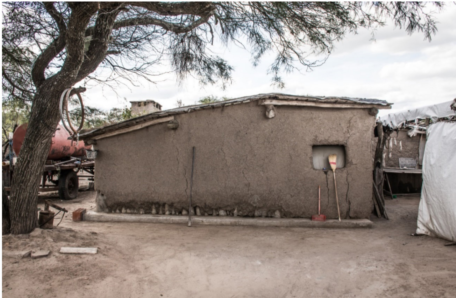
Ilustración 2. Casa de adobe en comunidad rural del norte de Córdoba. Autoría propia.
