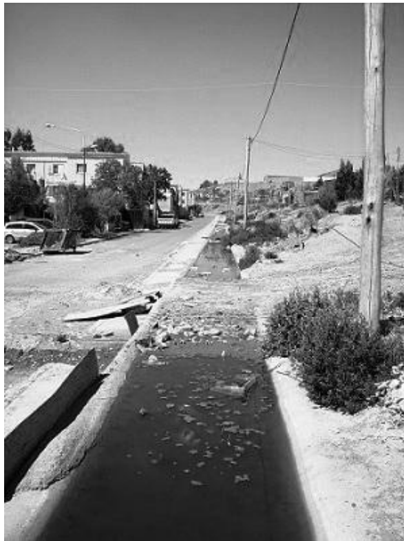
Imagen 2: Situación posterior a la intervención pública municipal. Enero 2013. Fuente: propia.
