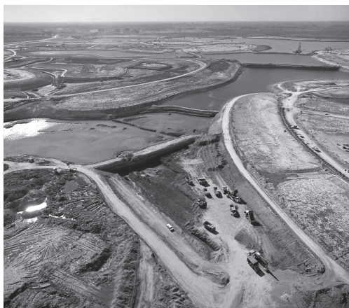
FIG. 3/ Movimiento de suelos y construcción del lago central de Nordelta
