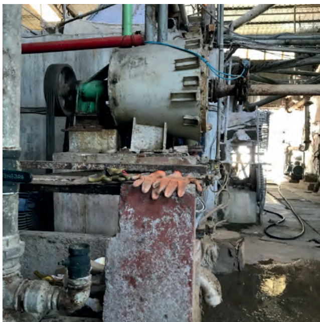
Ilustración 6: Ingreso a las tuberías para la pasta de papel Kraft. Fotografía propia.
