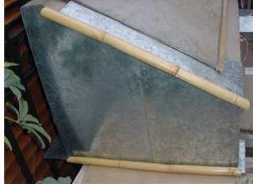
Figura 5: Ejecución de caja exterior. Colocación de protección hidrófuga. Ensamble de tapa con cubierta reflectiva y de subcomponentes laterales.
