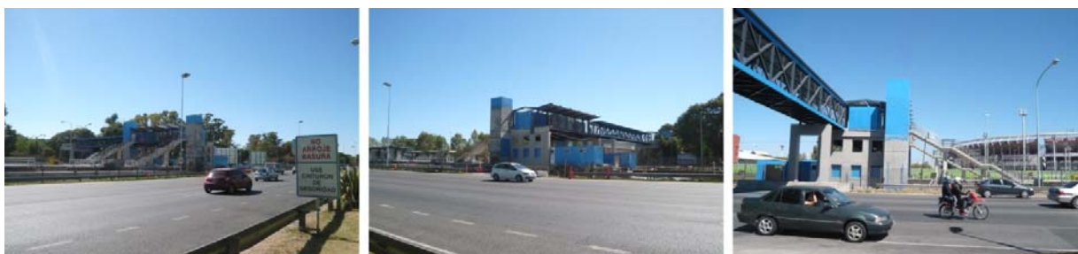
Figura 3. Construcción de la nueva Estación Ciudad Universitaria, 2015
