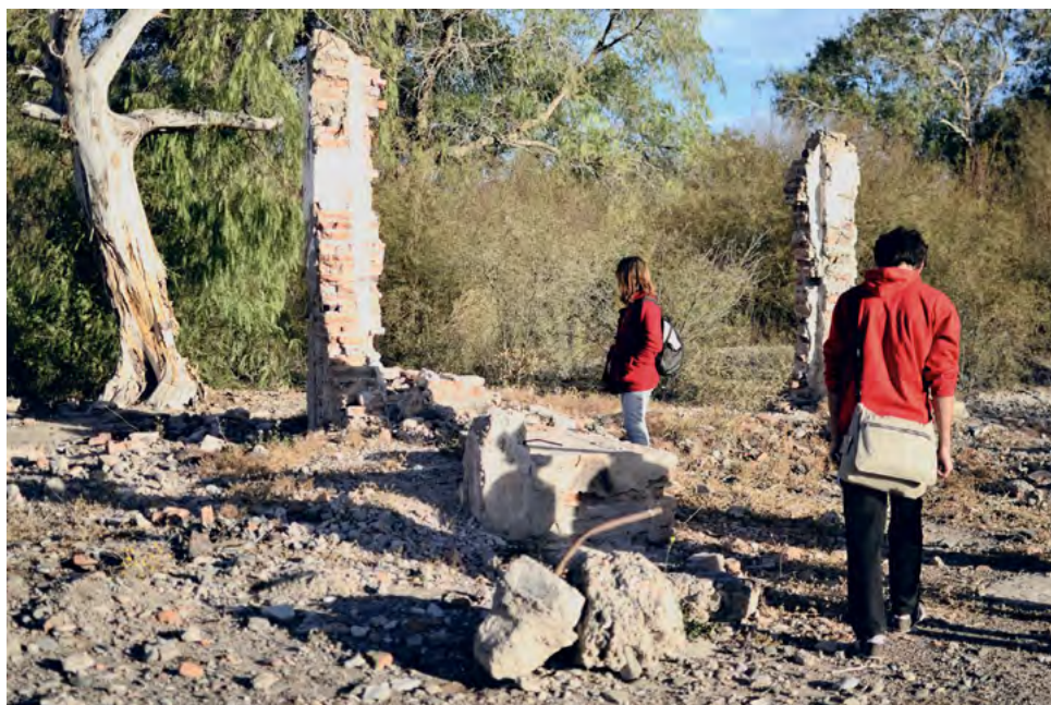
Figura 5. Vista del interior derrumbado (Sector norte) del ex CCD La Marquesita. Fotos del archivo del Ceiaa, 2014.
