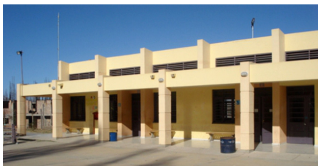
Figura 1. Acceso al edificio (arriba) y sector aulas crujía sur (abajo).
