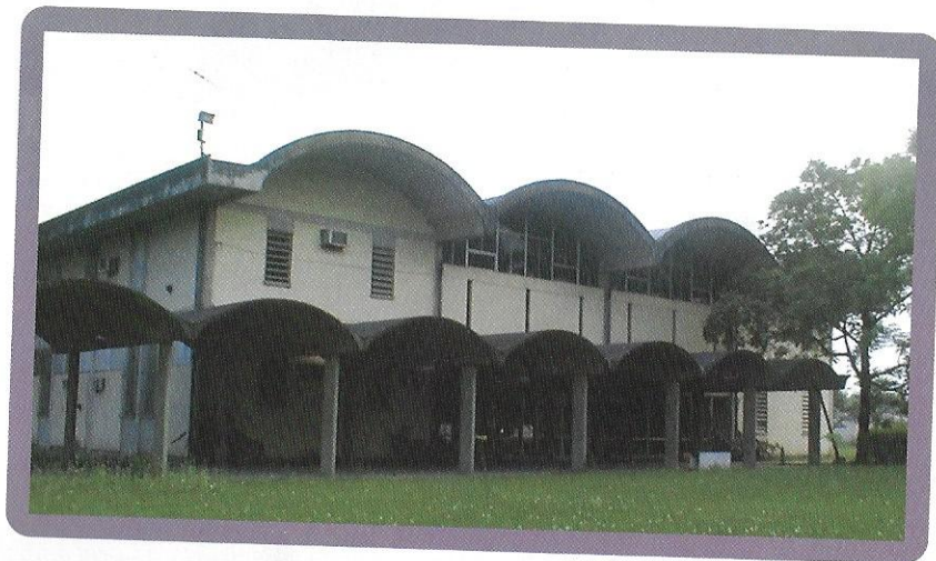
Figura 1.- Departamento de Luminotecnia, Luz y Visión (DLLYV) en Tucumán
