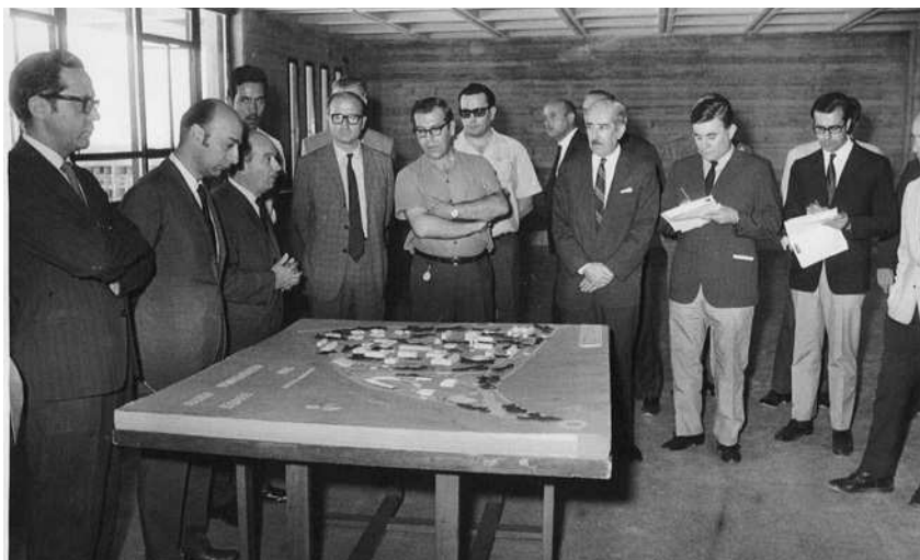
Figura 02. Aniceto Puig explicando los avances de las obras a autoridades nacionales, c.1969.
