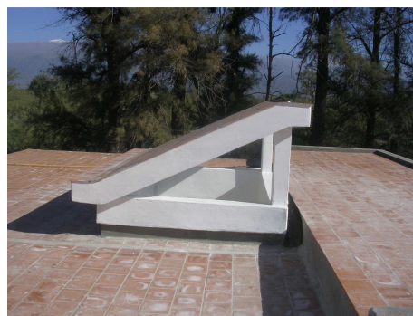
Fig. 4 Terminación techo modificado
