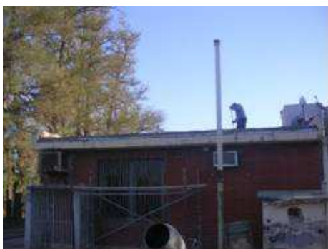
Fig. 3 Construcción techo con aislación
