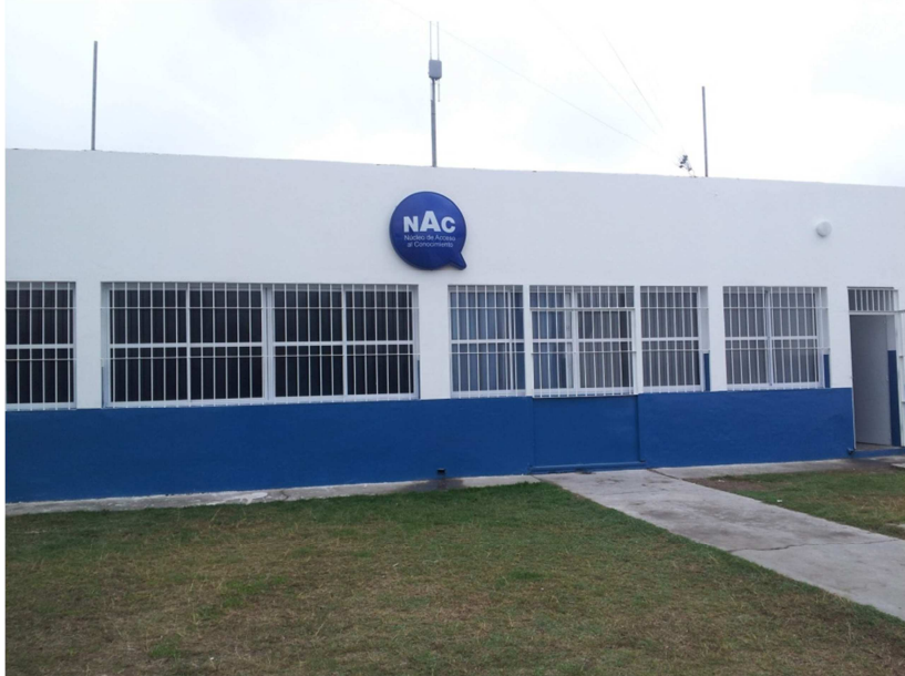
Figura 4: remodelación del antiguo dispositivo de encierro, para alojar el equipo del NAC.
