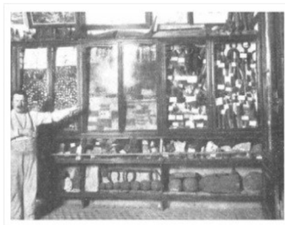
Fig. 7. Don Ángel Porretti en el interior del museo histórico modernista instalado en el despacho de bebidas de su casa, Caras y Caretas , n° 494, 21 de marzo de 1908.
