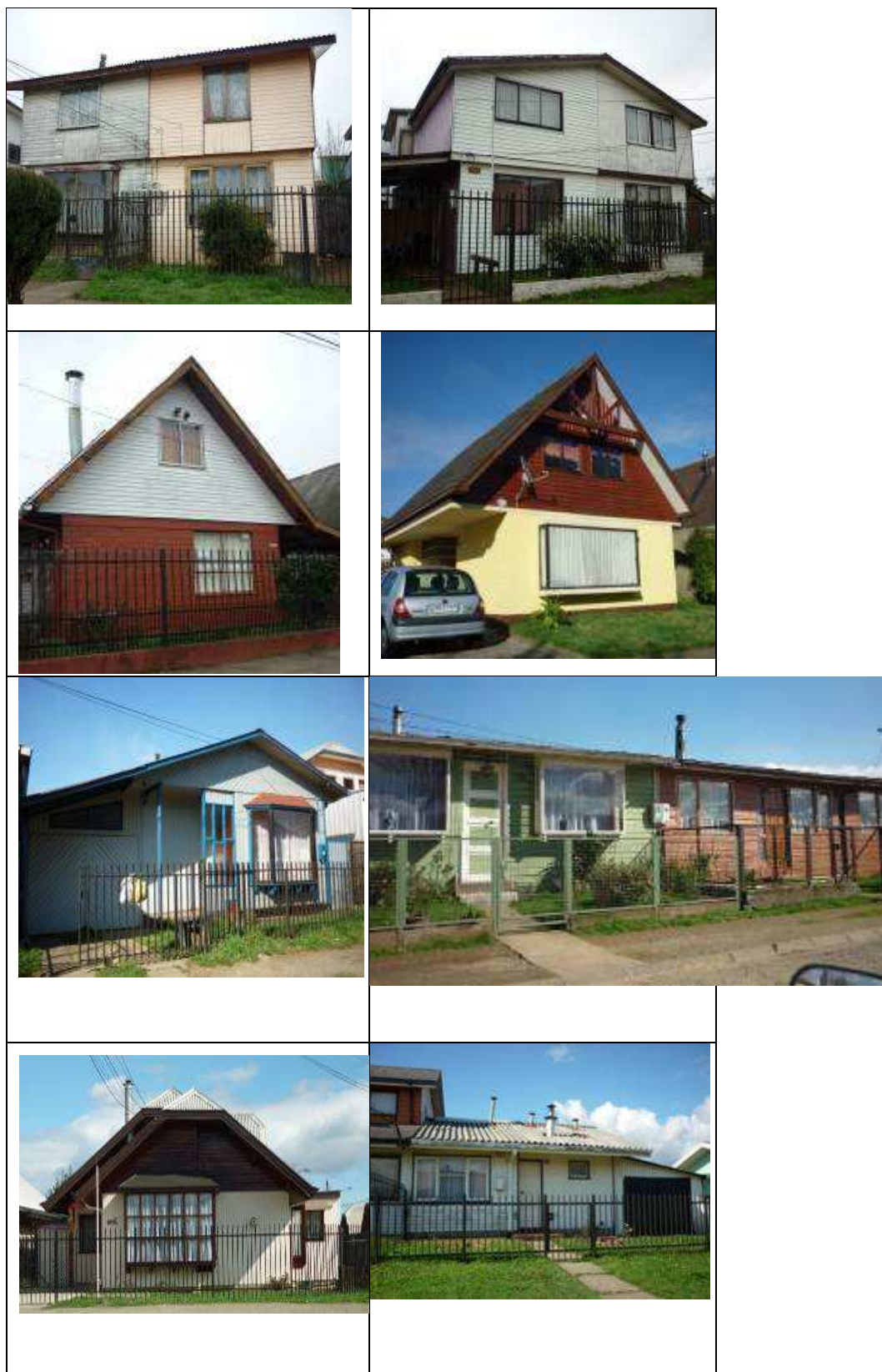
Figura 2: algunas tipologías de vivienda en la muestra analizada
